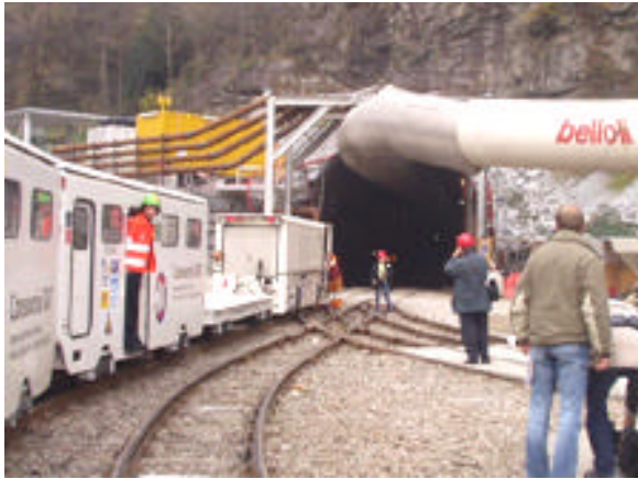
L'ingresso del tunnel di servizio dell'Alp Transit
